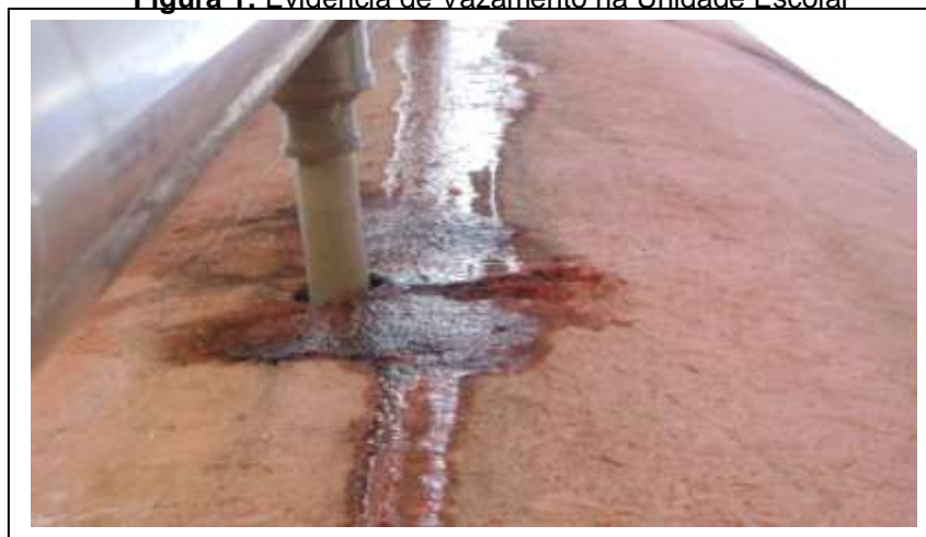
Figura 1: Evidência de Vazamento na Unidade Escolar
