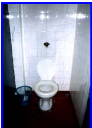
Válvula de descarga existente antivandalismo
